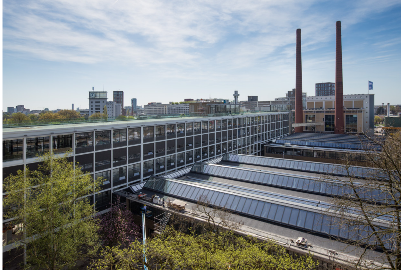
Strijp TQ, Eindhoven Deurautomatiek
